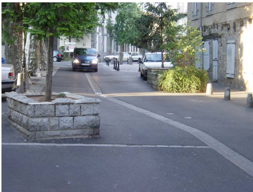
Figura B.41 - L'inserimento di elementi verdi migliora la qualità del design delle chicane
