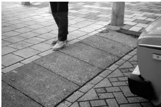
Figura B.14 - Particolare di una rampa realizzata con elementi prefabbricati in calcestruzzo, con pendenza del 10%
