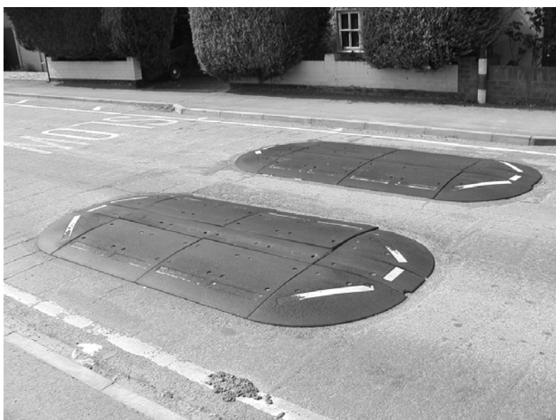
Figura B.31 - Una coppia di cuscini prefabbricati in materiale termoplastico
