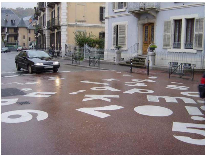
Figura B.13 - Un'intersezione rialzata in Francia posta davanti ad una scuola. I simboli posti sulla piattaforma rialzata invitano i pedoni ad attraversare anche in diagonale
