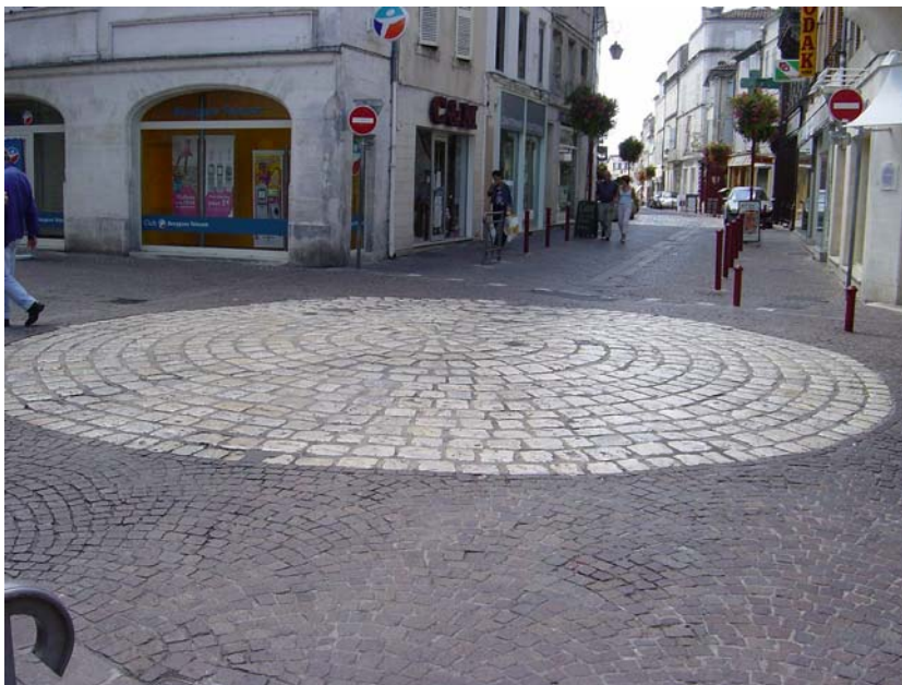
Figura B.22 - Una minirotatoria completamente sormontabile
