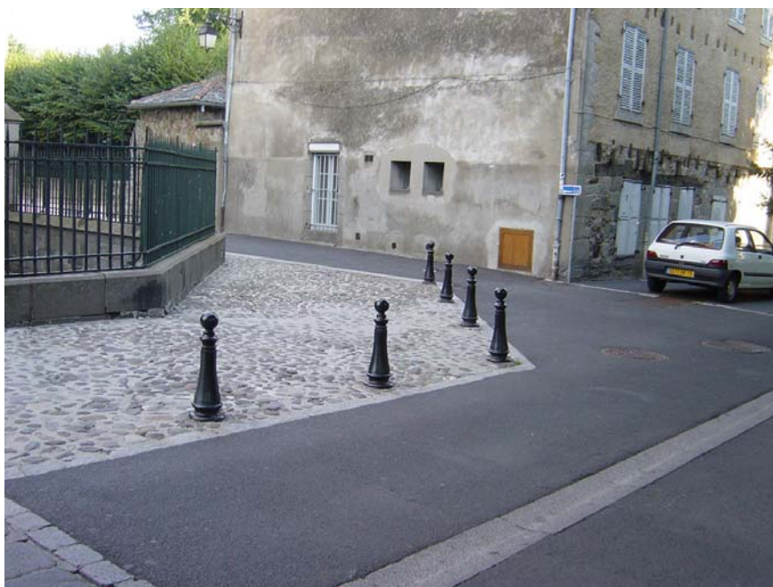
Figura B.35 - Una strettoia allarga lo spazio pedonale in corrispondenza di un'intersezione
