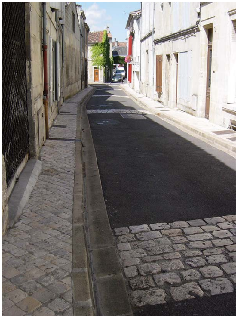
Figura B.30 - Una serie di bande trasversali a effetto ottico e vibratorio in una strada di un centro storico
